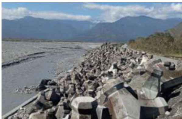
圖 3-130、康芮颱風萬里溪鳳林二號堤防緊急搶險完成
