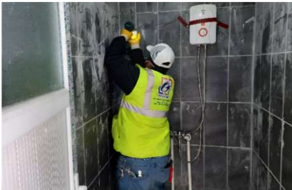
圖 3-202、「土耳其 Hatay 省地震災後 WASH 與健康照護服務可近性提升計畫」維修人員修復 Hilalkent 貨櫃屋城市淋浴間之電熱水器
