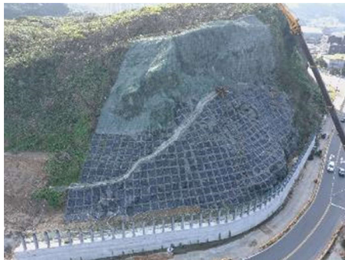
圖 1-27、自由型框格梁護坡施工
