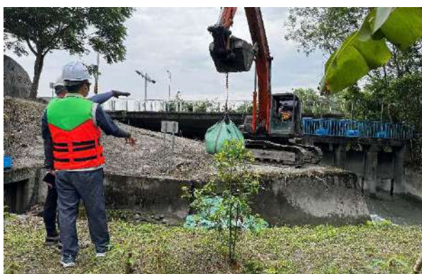
圖 3-84、花蓮豐田沉砂池大型機具吊掛太空包 資料來源：農業部
