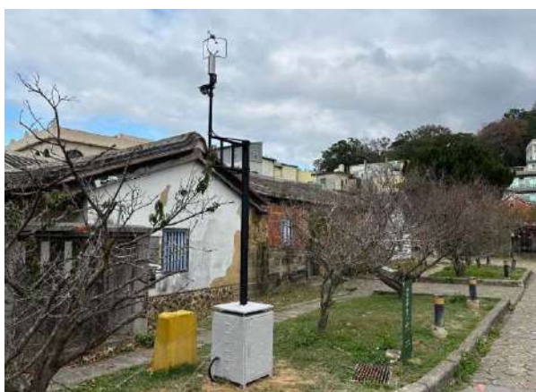
圖 3-52、保存環境監測設備（金廣福公館超音波三維風向風速計）
