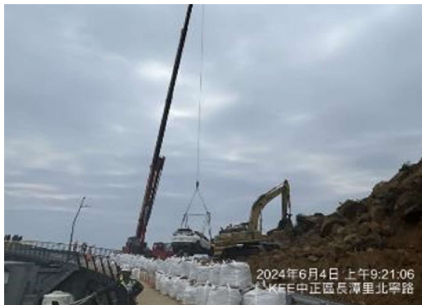
圖 1-24、現場吊離受困車輛
