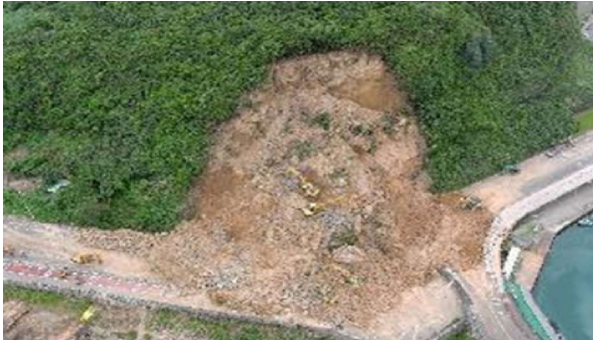
圖 1-25、現場受困車輛拖離、挖整第 1 平台
