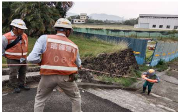
圖 3-107、在建工程防汛演練及整備
