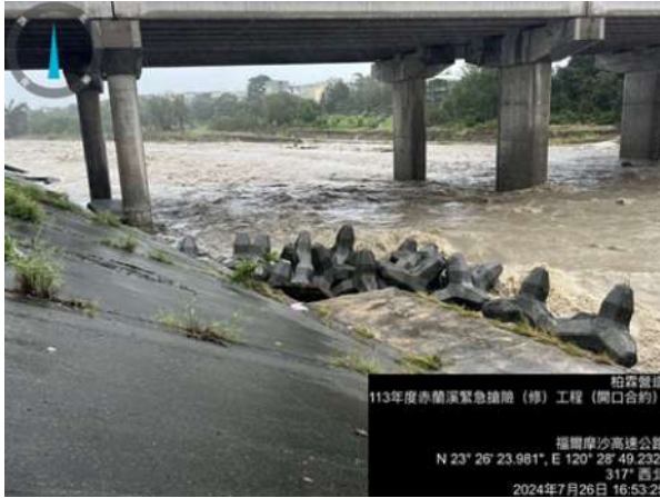
圖 3-126、凱米颱風赤蘭溪竹圍堤防緊急搶險完成
