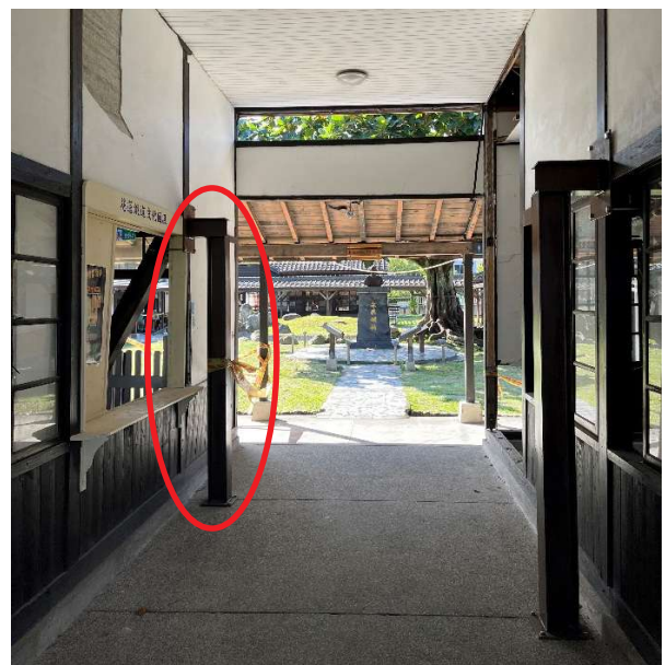
圖 1-21、鐵道文化園區緊急防護措施 2
