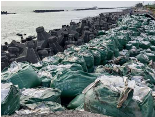
圖 3-128、山陀兒颱風屏東縣下寮海堤緊急搶修完成
