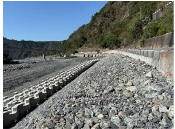
圖 3-127、凱米颱風濁口溪情人谷護岸復建完成
