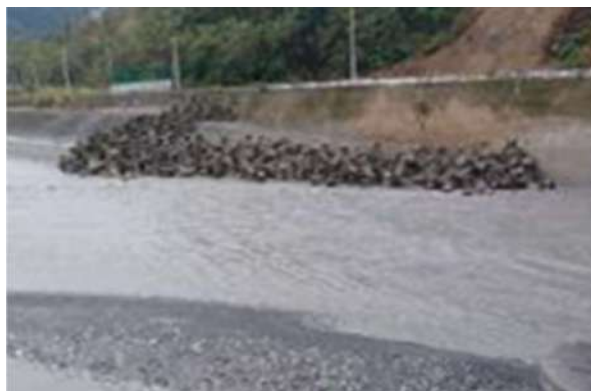
圖 3-131、康芮颱風豐坪溪中平護岸緊急搶修完成
