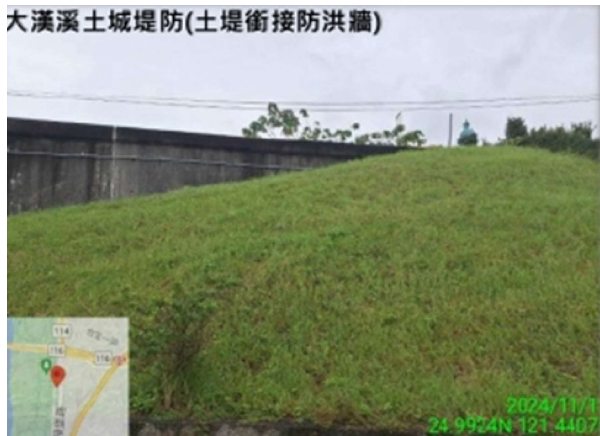
圖 1-32、大漢溪土城堤防（土堤接防洪牆）
