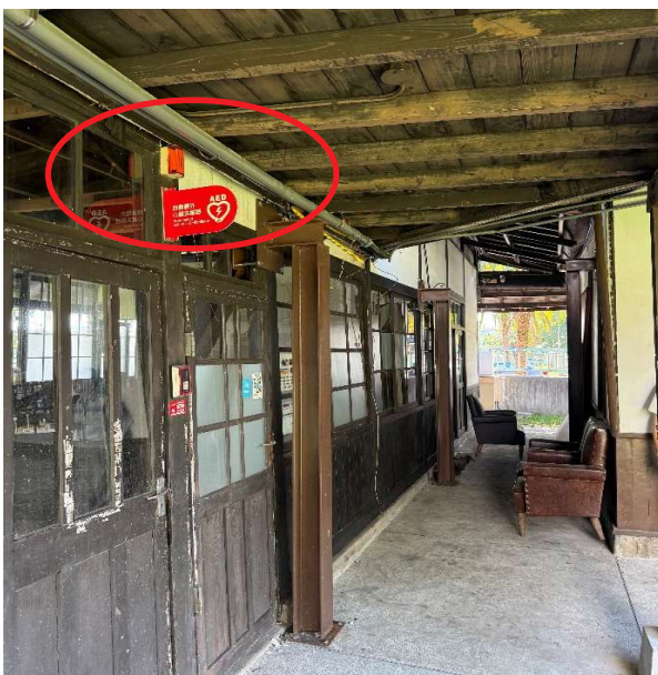
圖 1-20、鐵道文化園區緊急防護措施 1
