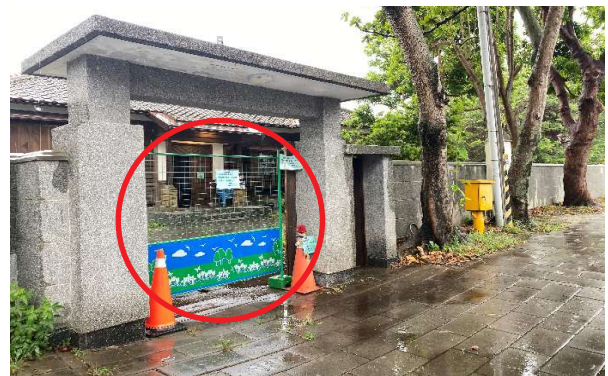
圖 1-19、檢察長宿舍緊急防護措施
