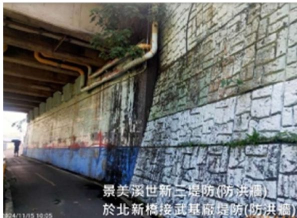
圖 1-33、景美溪世新三堤防接武基廠堤防
