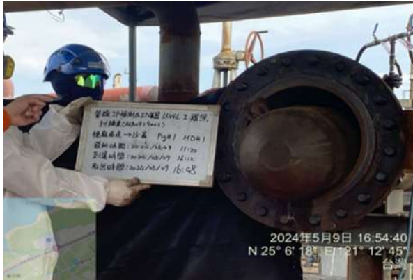
圖 3-9、精密檢測儀器放入管線內
