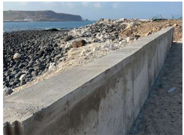
圖 3-129、山陀兒颱風澎湖縣東嶼坪海堤緊急搶修完成
